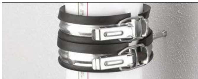
Fig. 3-6 Ferdig installerte lyddempende støtteklamme
